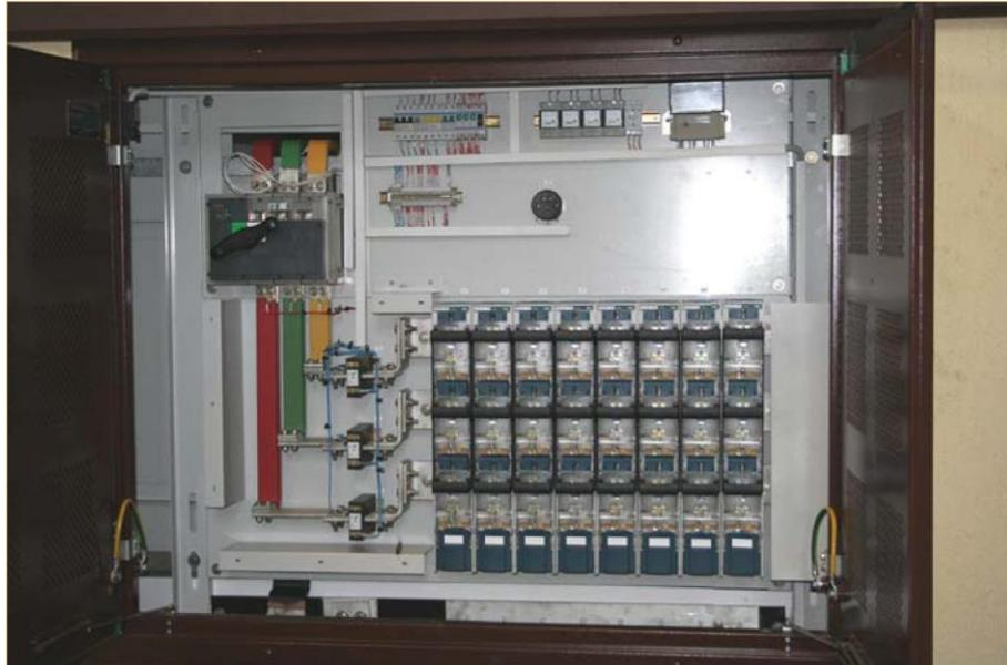
*Отсек распределительного устройства низшего напряжения (РУН)*
