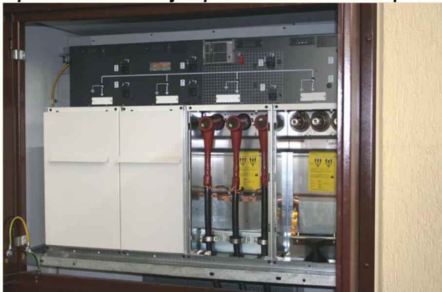
*Отсек распределительного устройства высшего напряжения (УВН)*
